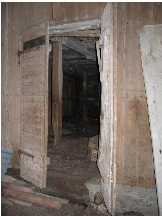
Ingång till svinhuset 2007
