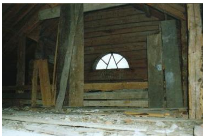
Ovanpå de södra gavelrummen
