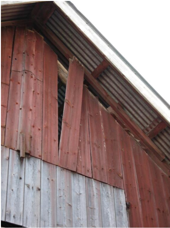
Till vänster: här man kan se att ladugården inte hade spåntak under till skillnad från vagnsboden (se längre ner). Foto från 2007.
