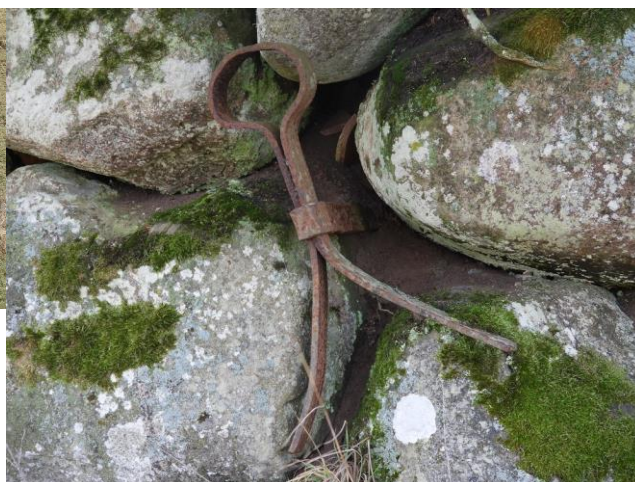
Ovan: resterna av tegelbruket sett från vägen vid Nyhagen. Skylden med blå topp är uppsatt av Habo torpinventering. Till höger: ett ankarslut på baksidan av ruinen. Foton 2019.
