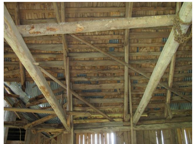
Det gamla spåntaket ligger här kvar under plåttaket. Vagnsboden 2012.
