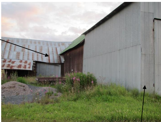
Vinkeln mellan vagnsboden och ladan ca 1945 (t.v.), 1950-tal (nedan) och 2012. På den senare bilden syns också tillbyggnaden med plåtväggar.
