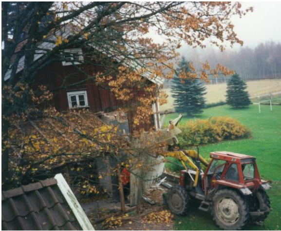
Rivning av uteplats och tvättstuga 1988
